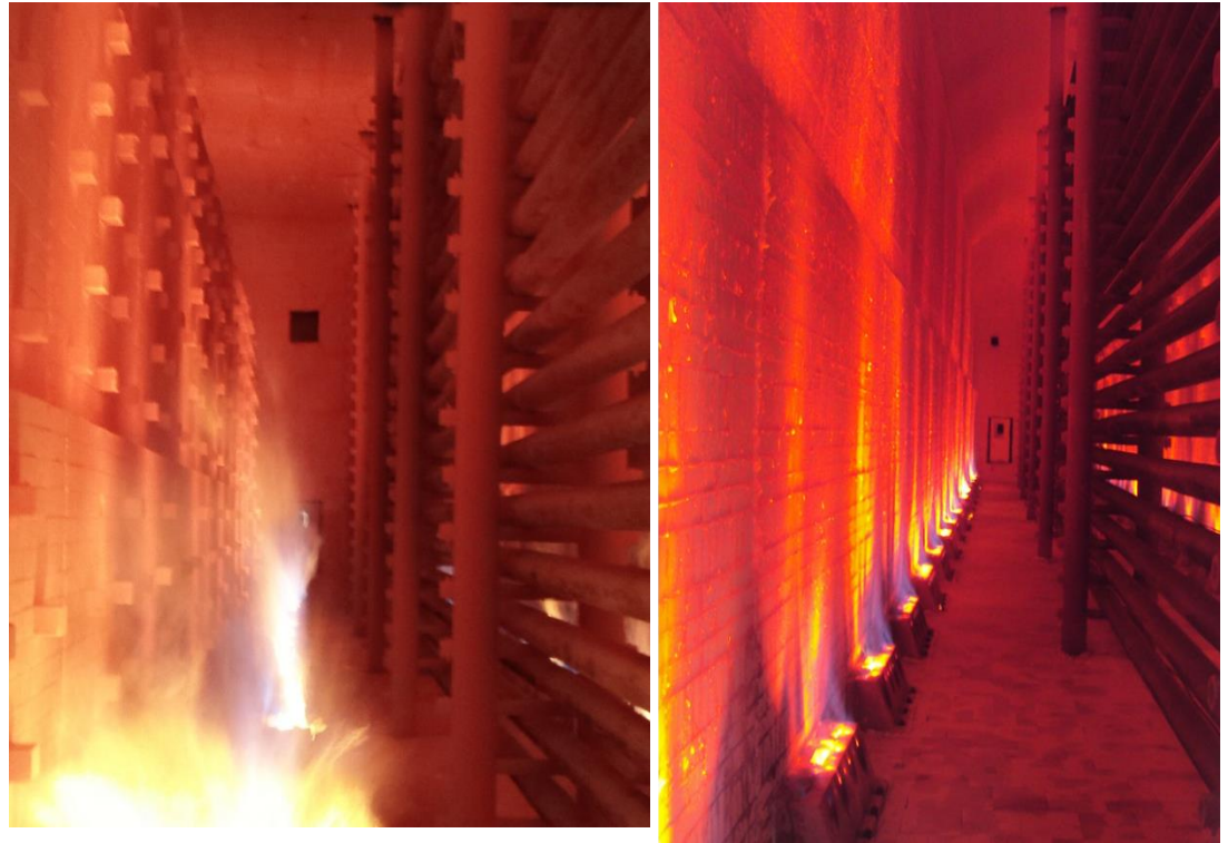
Сравнение пламени до и после реконструкции печи
