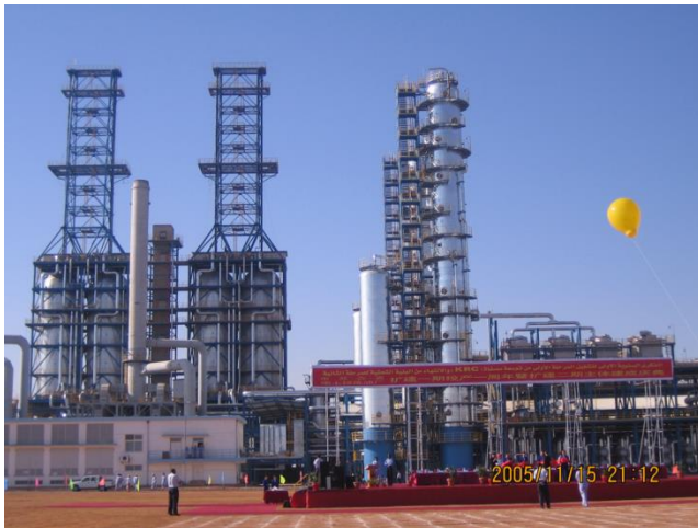
Панорамный вид на установку
