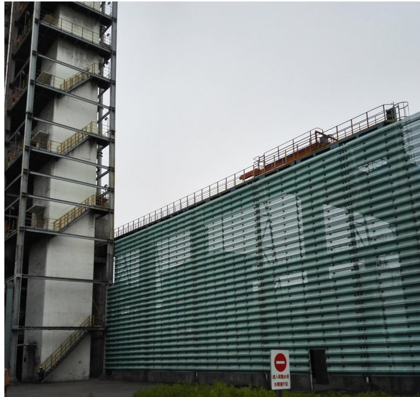
🔥 Ограждение коксового резервуара
