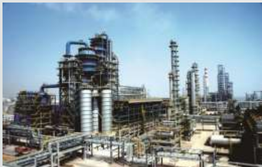
Установка каталитического крекинга
