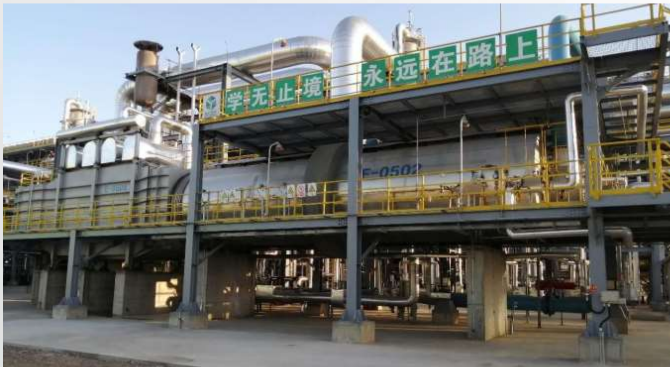
Dalian Hengli Установка по извлечению серы мощностью 650 000 тонн в год – крупнейшая установка, построенная компанией
